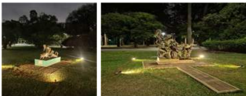
Figura 62: Instalação de iluminação na praça do porquinho e das cobras
