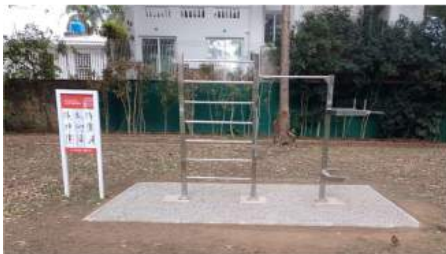
Figura 56: Execução de base para os equipamentos de ginástica e alongamento
