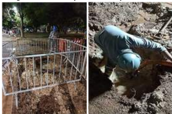
Figura 65: Manutenção em tubulação danificada
