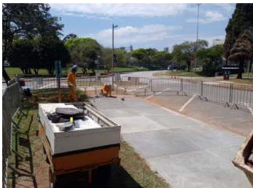
Figura 60: Manutenção de calçadas existentes
