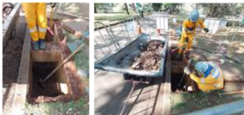
Figura 64: Limpeza das bocas de lobo e leão
